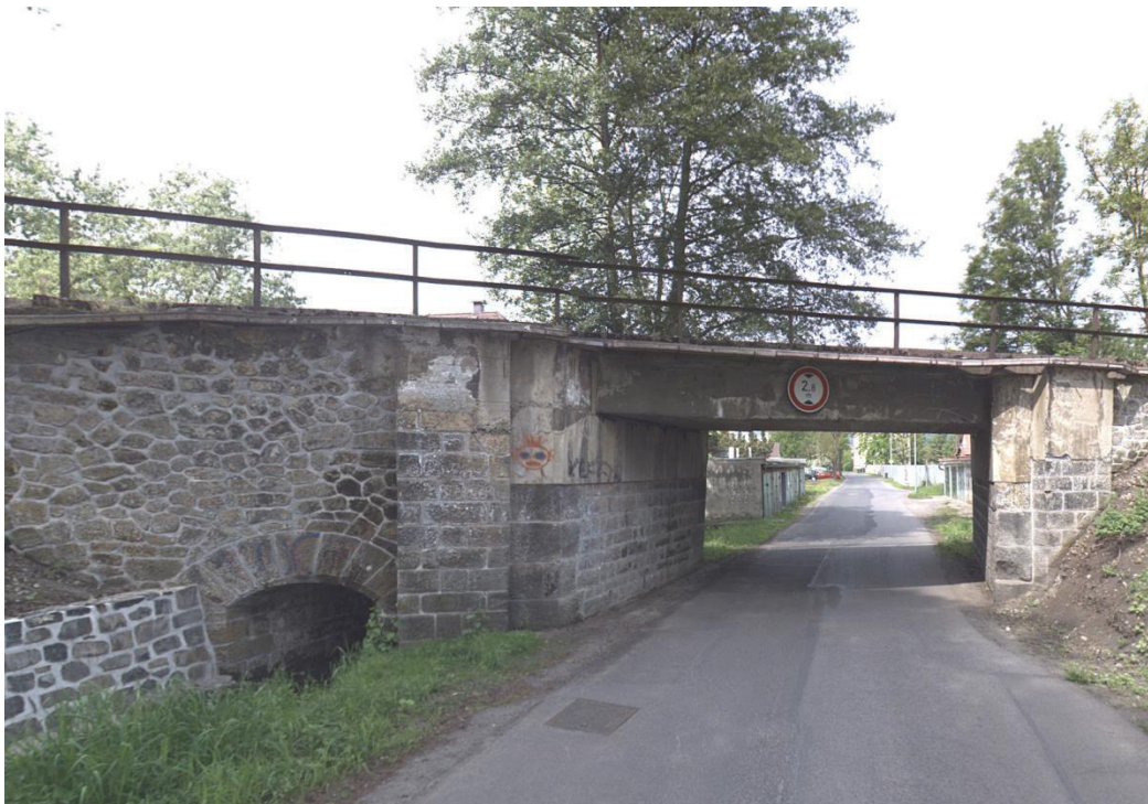
Obrázek 23 Nedostatečně vysoký podjezd v Brezové ulici (zdroj: mapy.cz)
